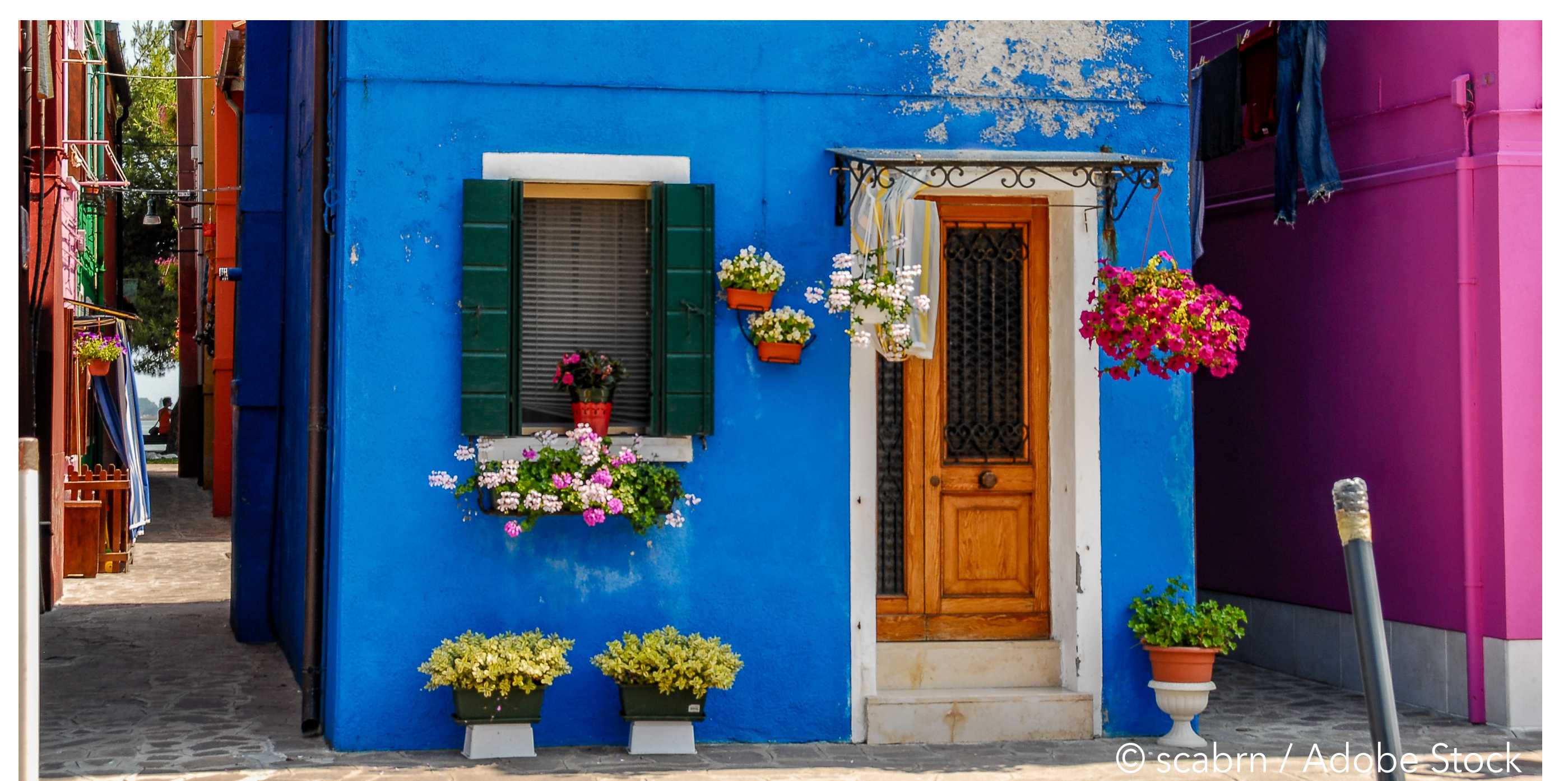
Erhöhte Eingänge schützen vor Überflutungen durch Starkregen
